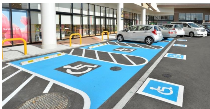
お体の不自由な方専用の駐車場
