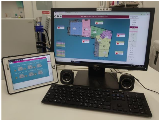
<防災センターに設置の中央監視盤で給気量を制御>
