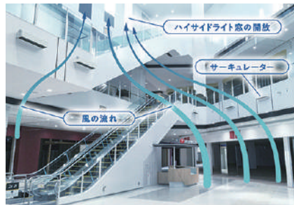
換気システムで空気循環を強化
