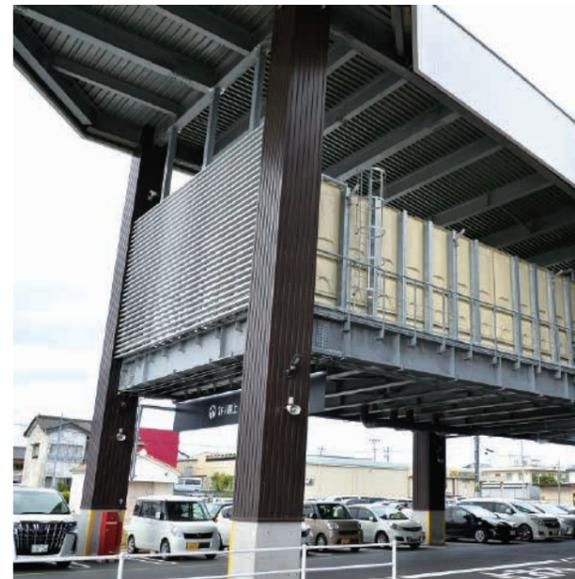
東日本大震災の経験から、津波や水害を想定して受電設備などを高い位置に設置し、受水槽から飲料水を取り出せる非常用バルブを取り付けるなど、災害を想定したモールづくりを進めてきました。地震の2次被害を防ぐために防煙垂壁をガラスから透明不燃シートに変更するなど、耐震性能も強化しています。国内ほぼすべてのモールが地方行政と防災活動への協力などに関する協定書を締結し、万一の際に防災拠点として機能する体制を整えています。
