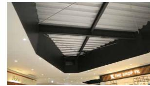
吹き抜け空間の天井は、単位面積当たりの重量を軽量化することで落下による二次被害を最小限に抑えています。
