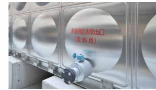
耐震性を有した受水槽は、断水・停電状態においても飲料水を利用できるように緊急用給水口を設置しています。
