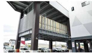
受電設備などの重要機器は、津波や水害による浸水の影響を受けない高い位置に設置しています。
