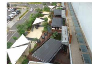
カフェストリートの庇上部に結晶太陽電池モジュールを設置
