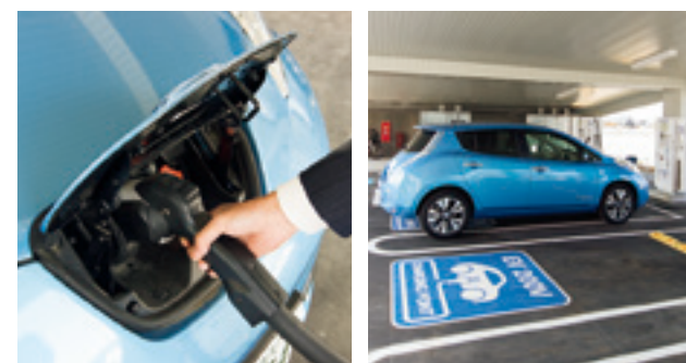
EV充電器をつないでいる様子
