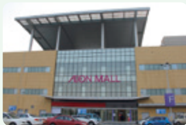
ソーラーパネルを設置した屋根
