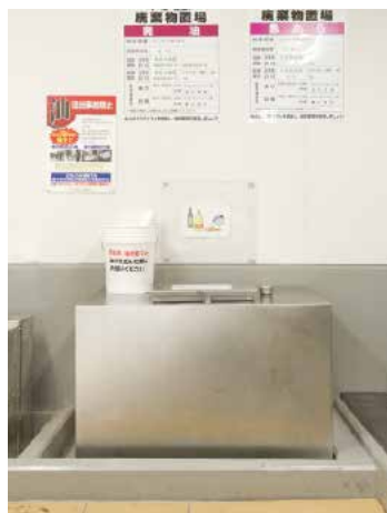
ごみ庫内に設けられた防油堤
