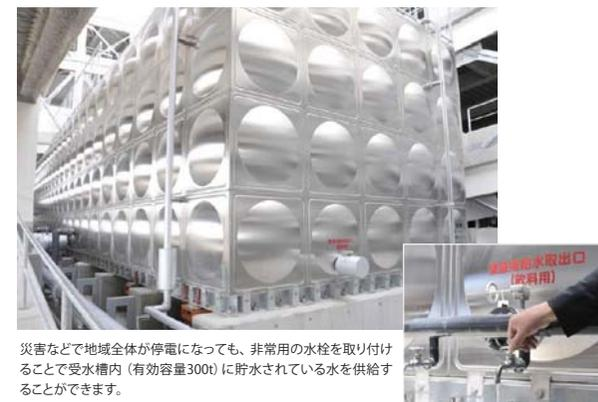
災害などで地域全体が停電になっても、非常用の水栓を取り付けることで受水槽内（有効容量300t）に貯水されている水を供給することができます。
