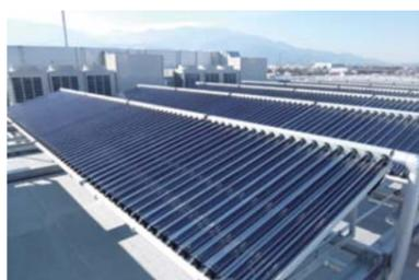
■ 東京ガス(株)が開発した「ソーラークーリングシステム」を国内の民間商業施設として初めて採用。ソーラー集熱パネルで太陽熱を集めて作られた温水を夏は冷房に、冬は暖房に利用できる先進の環境設備です。
