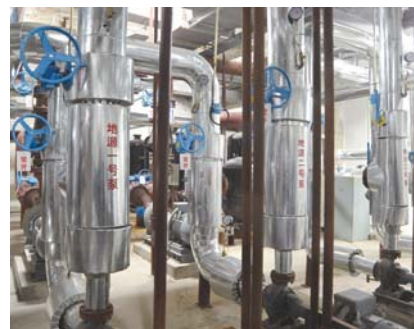
地熱で外気を熱交換してから空調に利用し、環境に与える負荷を軽減しています。
