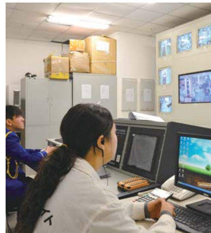
防災センターでは128台のカメラで館内に異常がないかをモニタリングしています。
