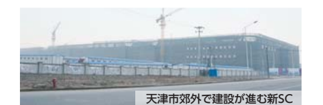
天津市郊外で建設が進む新SC
