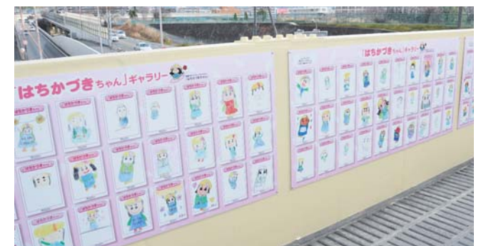
きれいに再塗装されたSC前の緑町歩道橋。お子さまの絵を飾って明るいイメージに生まれ変わりました。
