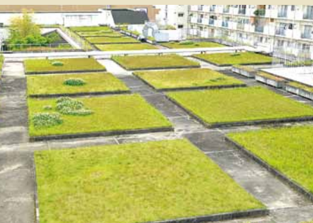
27年前から導入している屋上緑化。景観だけでなく、夏季の室内温度を下げる効果も実感できる（京都ファミリー）
