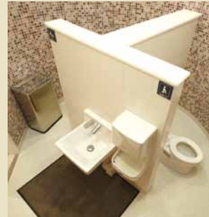
子ども用のトイレも設置
