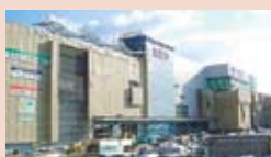
建設中のDCソレイユ
