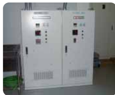
電力使用量の削減に 貢献するインバーター 制御装置
