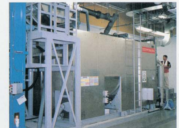
生ゴミ処理機(1日処理能力/1,000kg) 東浦SC
