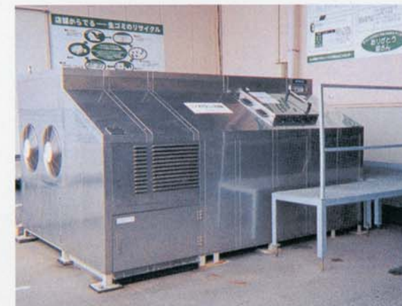
生ゴミ処理機(1日処理能力/200kg) 秋田SC
