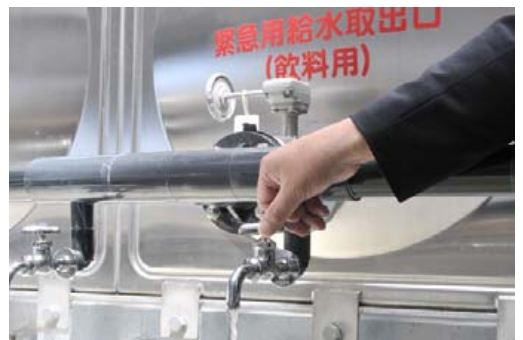
（「受水槽仮設給水口イメージ」）
