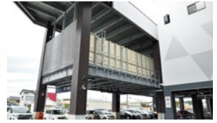
受电设备等重要设备安装在高处，以免在海啸和水灾中遭到水浸。
