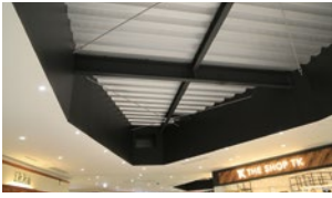
减小了挑空区域顶棚的单位面积重量，最大限度地减轻由坠落引起的二次伤害
