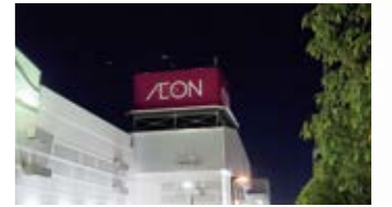
关闭部分户外照明
