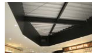
减小了挑空区域顶棚的单位面积重量，最大限度地减轻由坠落引起的二次伤害
