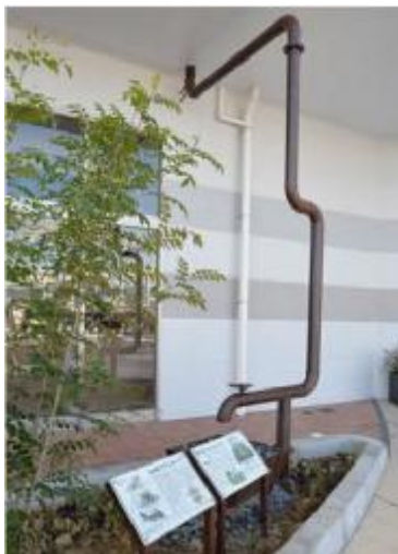
【雨水を土壤に浸透させ利用する「雨の庭」】
